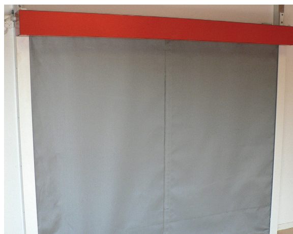
Automatyczna kurtyna dymowa w pozycji opuszczonej
